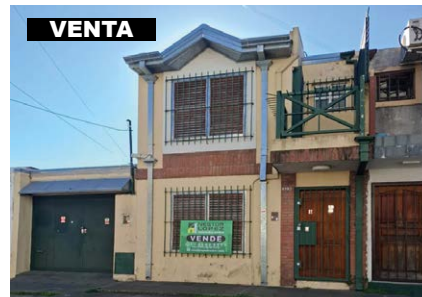
VENTA DUPLEX 13 y 142 Berazategui, listo para habitar, en 2 pantas. cocina-comedor, baño para visitas, 2 habitaciones, baño completo y patio con parrilla. U$S 86.000 Se Escuchan Ofertas
