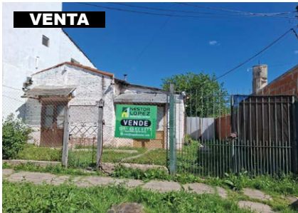
VENTA TERRENO en 15 e/131a y 132 Berazategui, apto desarrollo inmobiliario, superficie 450 M2 aproximadamente. Consultenos.
